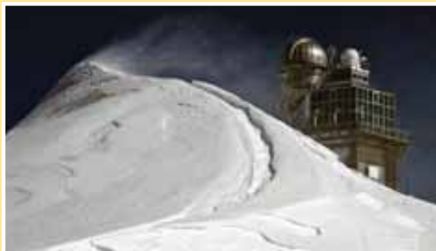
Станция наблюдения ГСА на Юнгфрау (3 580 м над уровнем моря), Швейцария.
