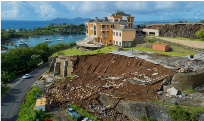
Figura 5: Derrumbe del Jax wall en Ratho Mill
