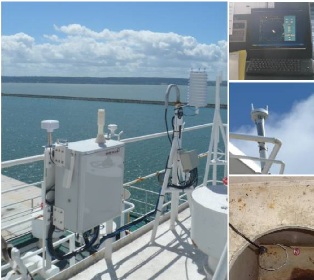
Figure 15: Installation on CMA-CGM Fort Sainte Marie (Météo-France)
